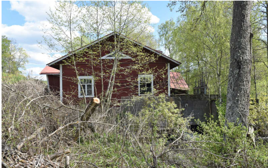
Kuva: Konehuoneen sisältävä siipi luoteeseen.
