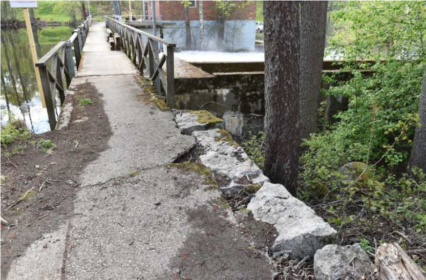
Kuvat yllä ja alla: Säätöstely- ja voimalaitospadolle johtavan kulkuväylän kivistä ladottu tukimuri. Länsiranta. Kulkuväylä on jälkeenpäin päällystetty.
