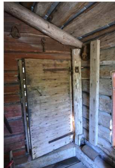
Kuva: Turbiinikammion yläpuolisen tilan sisätilaa.
