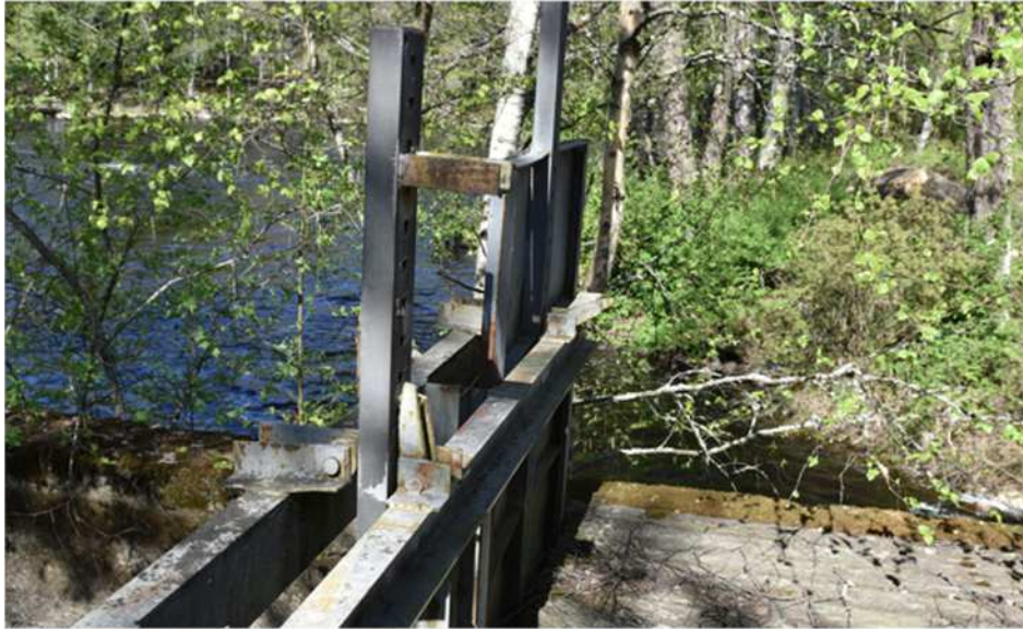
Kuva: Teräslevyluukku betonikourun luoteispäässä.
