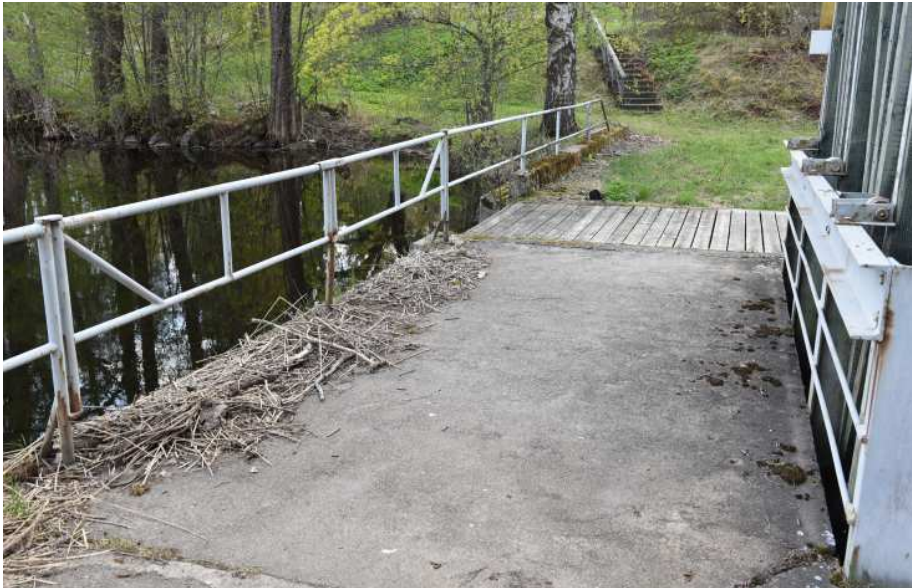
Kuva: Patosillassa vaihtelevat puu- ja betonikannet.
