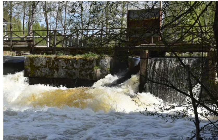
Kuva: Lohkokivisen osan oikealla puolella oli ennen uittoruuhin aukko.
