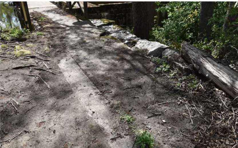
Kuvat yllä ja alla: Säätöstely- ja voimalaitospadolle johtavan kulkuväylän kivistä ladottu tukimuri. Länsiranta. Kulkuväylä on jälkeenpäin päällystetty.
