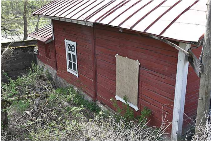
Kuva: Meijeripuolen kivijalassa on luonnonkiviä, hirret näyttävät kierrätysmateriaalilta (pätkiä, ulkopinnassa tapitusreikiä). Ikkunoiden malli palautuu 1890-luvulle.
