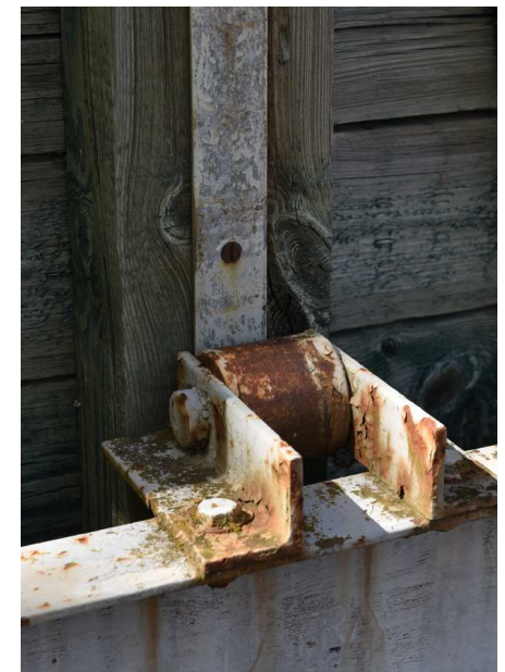
Kuva: Puuluukun metallirulla.
