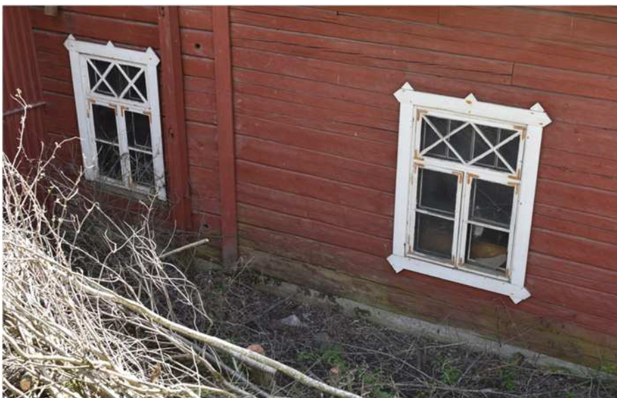
Kuva: Följärin oikealla puolella olevan pystylistan alle jää seinän liitoskohta. Ikkunoiden eri-ikäisyys näkyy karmien ja ulkopokien rakenteessa, ja heloituksessa. Vuorilaudat on uusittu vanhan mallin mukaan.
