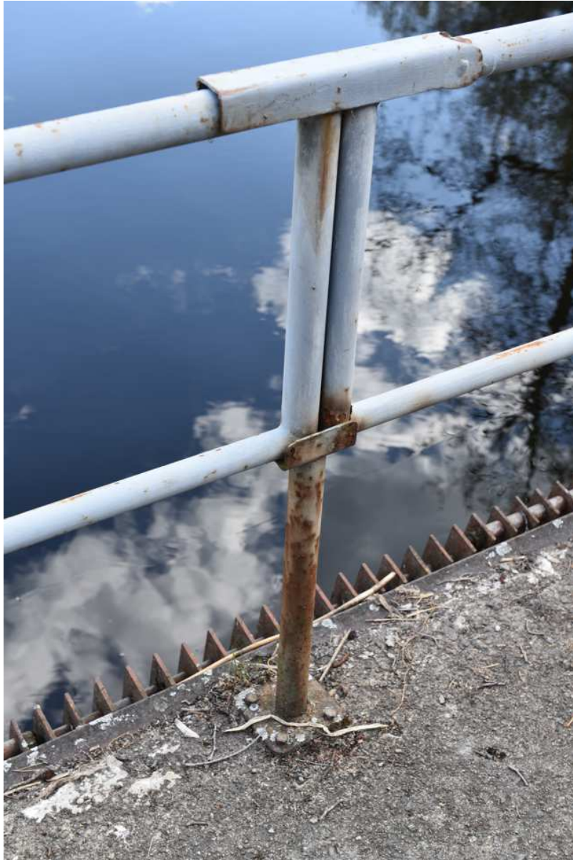
Kuva: Välppien kohdalla metallikaiteessa on portit.
