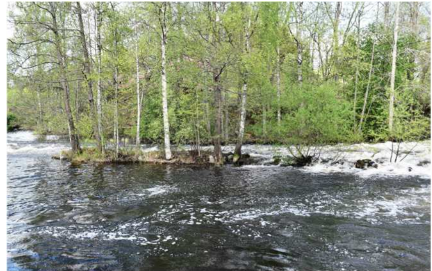
Kuva: Koskiuoman välirikannas on kasattu, ei ladottu, luonnonkivistä.
