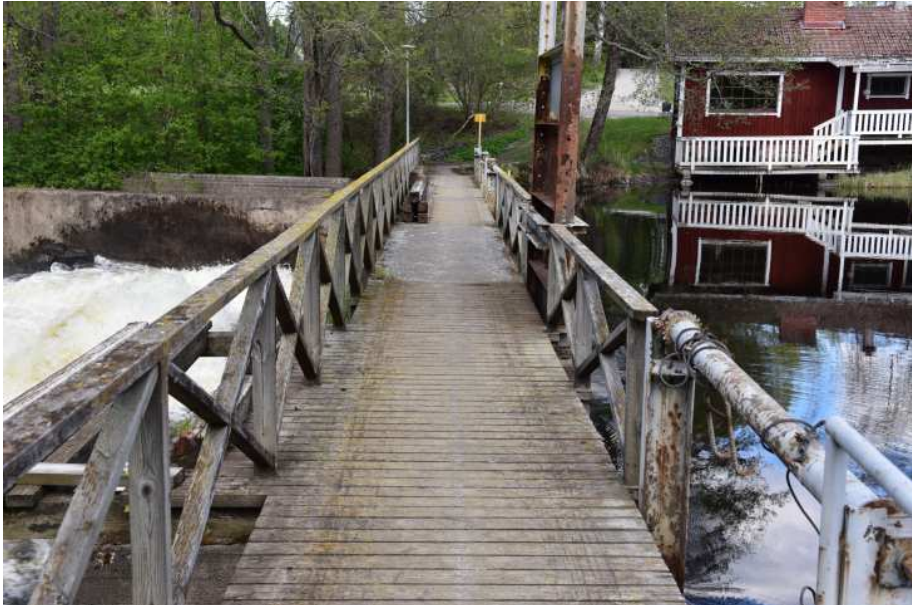
Kuva: Puukansien kohdalla on ristikkokaiteet.
