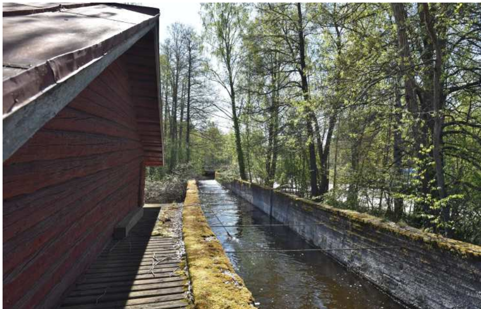
Kuva: Betonikourua on vahvistettu terästangoin, myös vedenalaisessa osassa.
