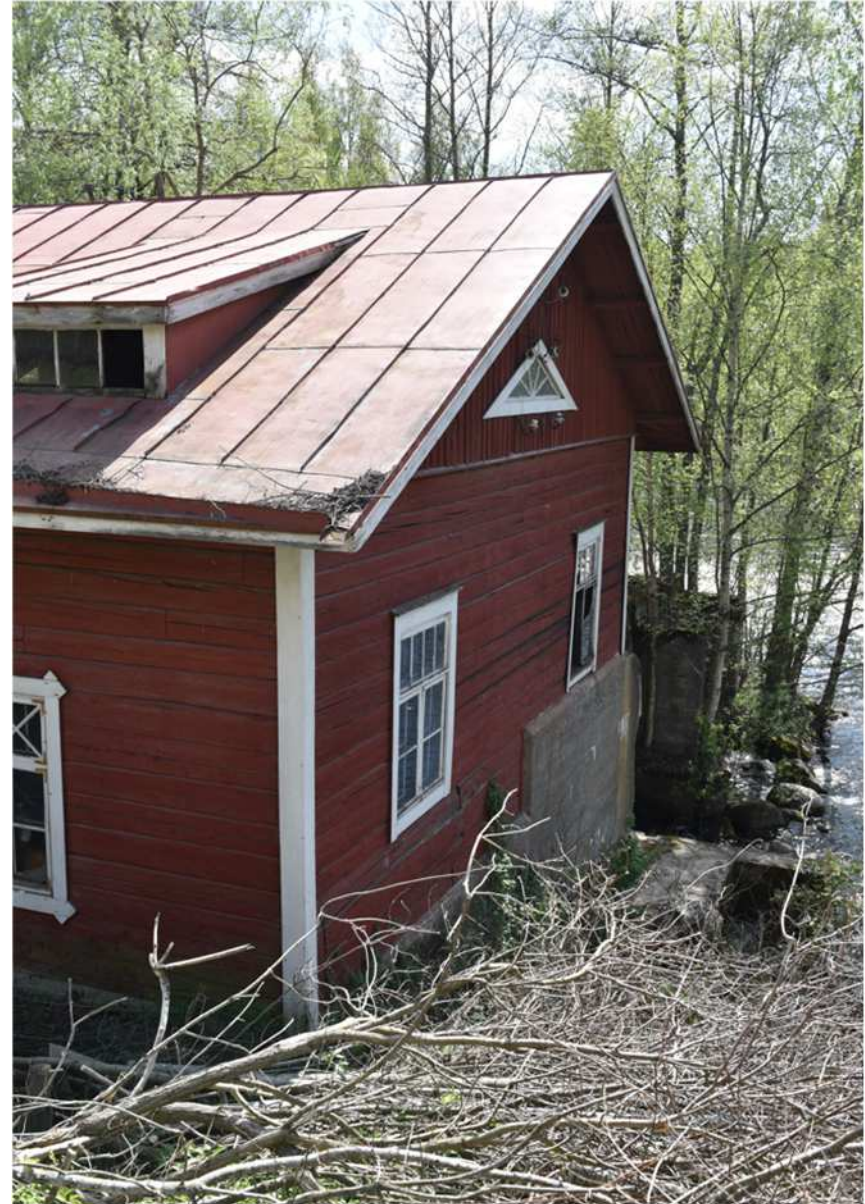
Kuva: Konehuoneen pääty. Ullakkopääty on lautta eikä hirttä, kuten vanhassa meijerirakennuksessa. T-ikkunoiden yläpuiteen jako eroaa meijeripuolen ristiruutuisesta puitteesta.
