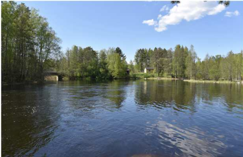
Kuva: Kuva otettu vanhan siltapaikan luota 1960-luvun alussa rakennetun maantiesillan suuntaan.
