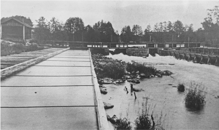
Kuva: Pato ja vanhalle vesimyllylle johtava vesikouru. Patosillalla yksinkertainen puukaide. / Kuva julkaisusta Stjernvall-Järvi 2007, Anna Soria Hyytiän albumi.
