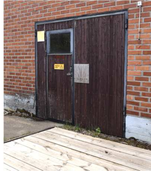
Kuva: Metallikarmit ja pystypaneeliovet.
