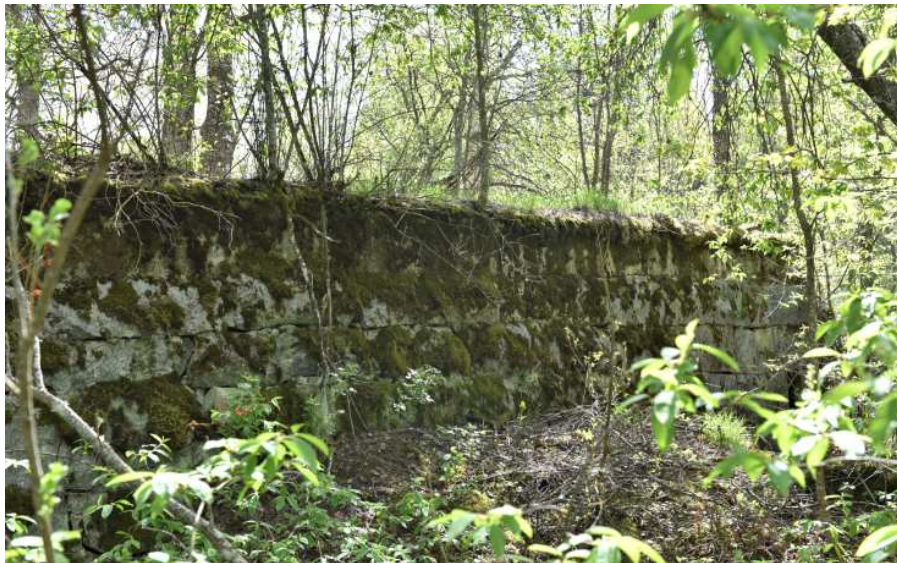
Kuva: Vanhan maantien korkeaa lohkokivistä tehtyä tukimuuria virran itärannalla.
