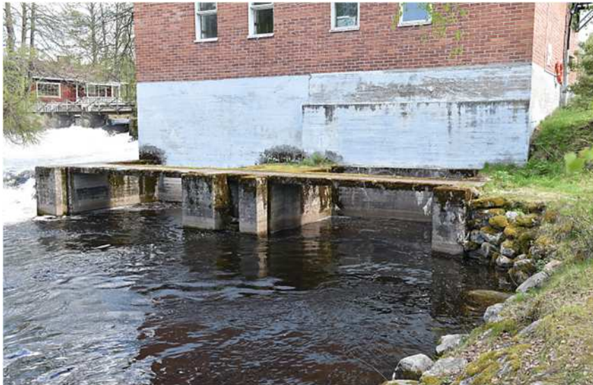
Kuva: Voimalaitoksen betonisoskelissa erottuu kahden turbiinikammion eriaikaisuus.
