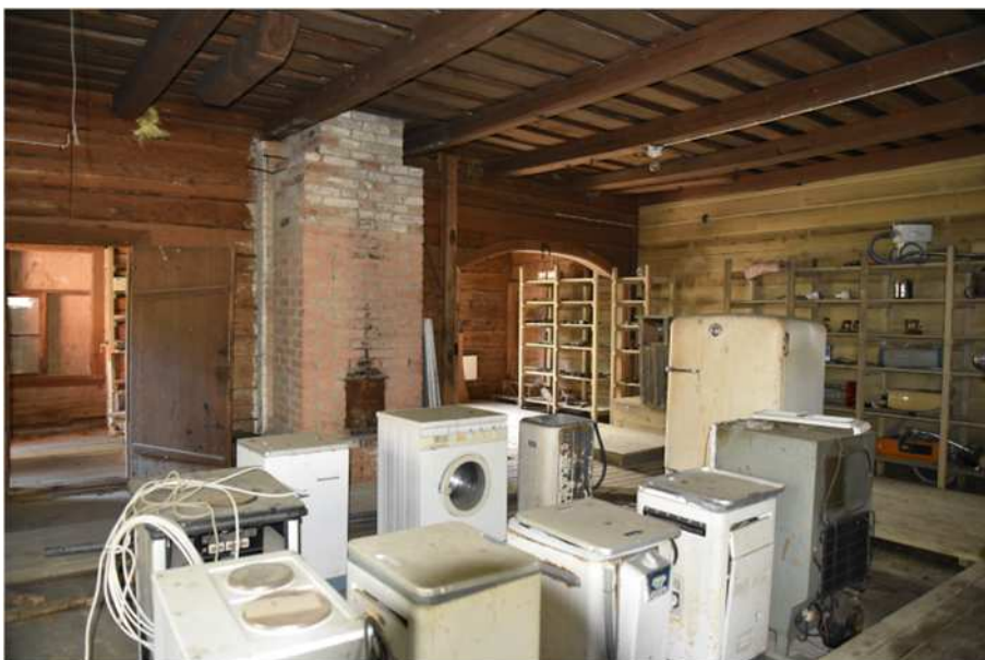
Kuva: Meijeripuolen keskellä olevaan hormiin liittyy kaksi pystyvuonia. Palkkikatto ja alapinta leveistä lankuista. Lattiatasossa laudoitusta ja betonia.
