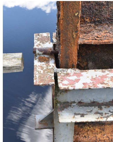
Kuva: Teräsluukun lukitustapit päädyissä.
