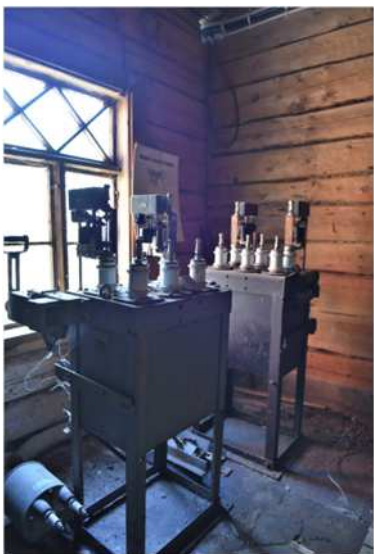
Kuva: Katolta puretun muuntamotornin alapuolinen huone.
