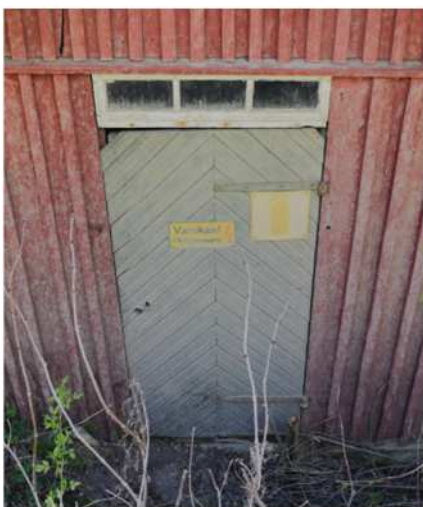
Kuva: Lautaseinäinen eteisen sulkapaneeliovi.
