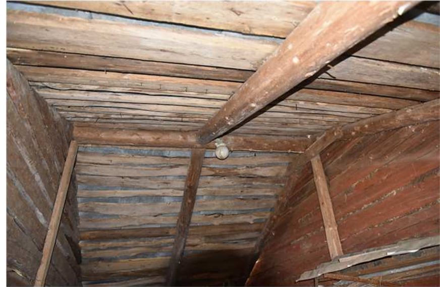
Kuva: Kosken puoleisen vanhan turbiinihuoneen yläpuolinen tila. Punamullattu seinä on meijerin entistä ulkoseinää.
