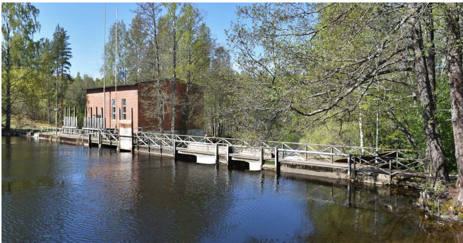
Kuva: Virtaankosken pato. Padon läpi virtaavan veden määrää säädellään aukkojen ja luukkujen avulla. Padossa on sekä luonnonkivistä kylmämuurattuja että betonista valettuja osuuksia, ja niiden yhdistelmiä. Patosillan kannet ovat vuorotellen joko betonista valettuja tai lankkuista ladottuja, ja kannen mukaisesti kaitteet joko metalli- tai puurakenteisia.
