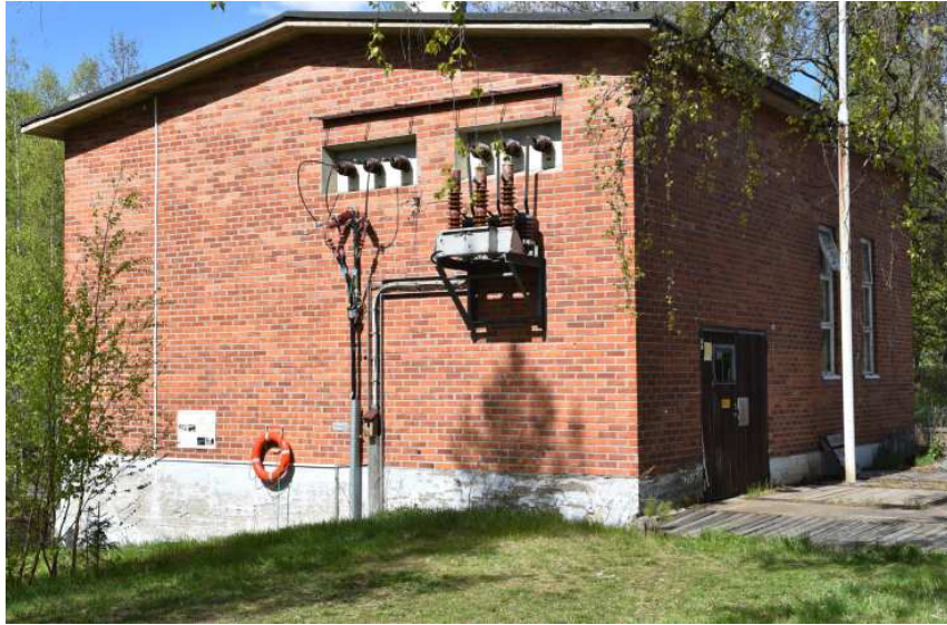
Kuva: Rakennuksen rannanpuoleinen turbiinikammio on rakennettu jokunen vuosi aikaisemmin kuin kosken puoleinen.
