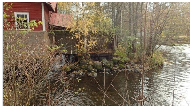
Betoninen uittoränni kosken itärannalla ja sen pohjoispää vanhan myllyrakennuksen kupeessa
