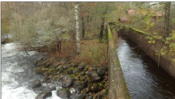
Betoninen uittoränni kosken itärannalla ja sen pohjoispää vanhan myllyrakennuksen kupeessa
