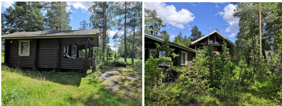
Rakennuskantaa, johon kuuluvat mm. lomarakennus sekä pienempiä talousrakennuksia.
