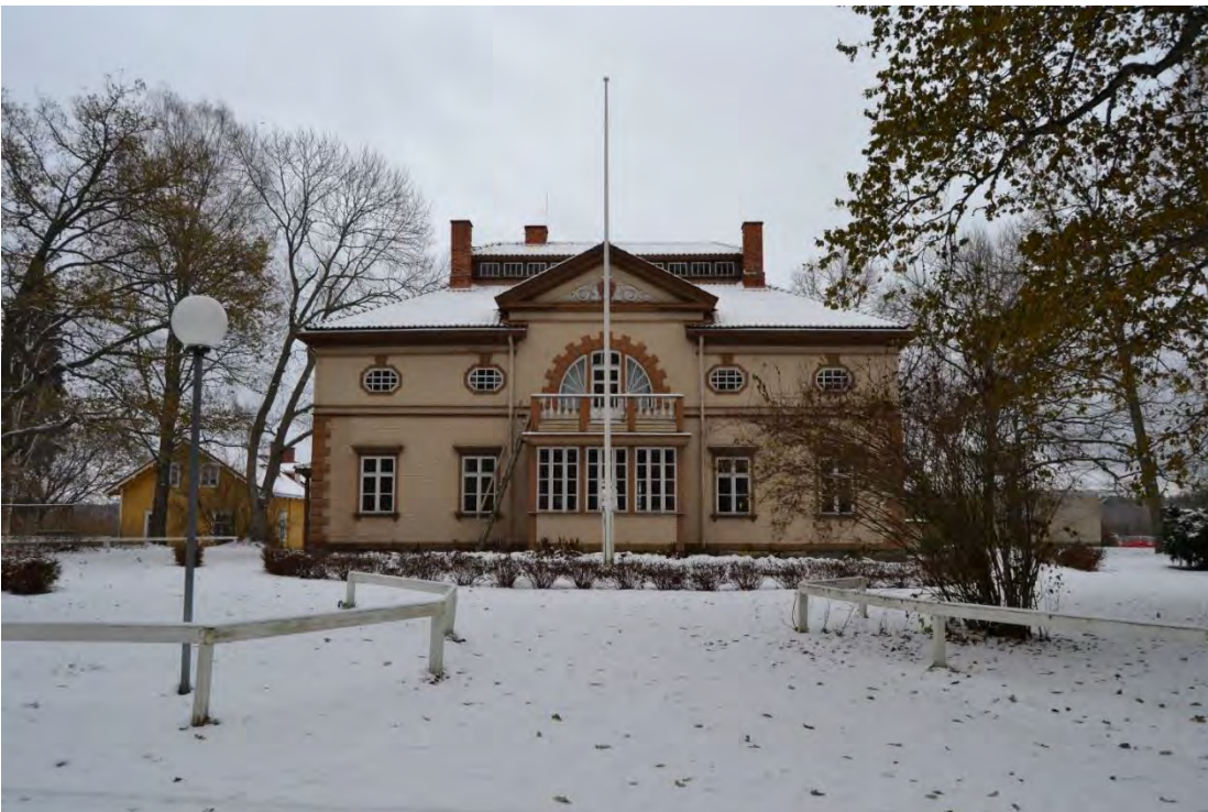
Kuva 18. Päärakennus kuvattuna pohjoisesta, laivarannasta päin marraskuussa 2023. Rakennuksen pohjoissivun erkkerin päällä on avoparveke.
