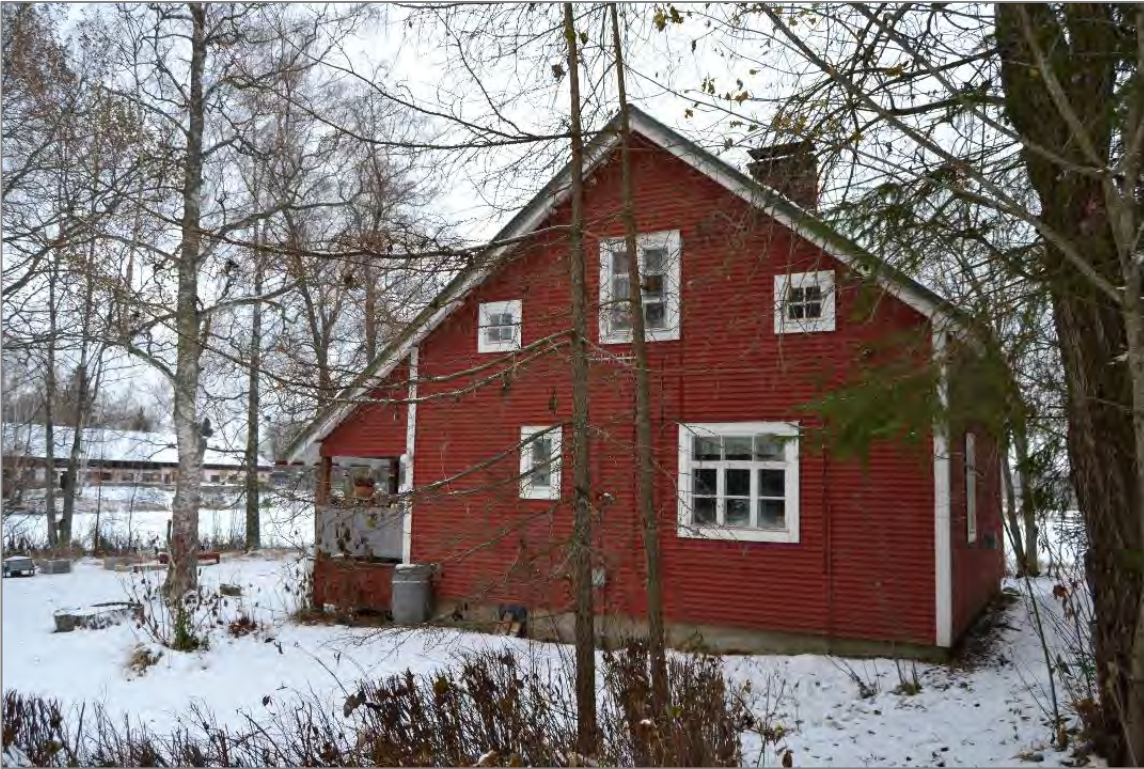
Kuva 46. Rakennus nro 12, pohjoispääty.
