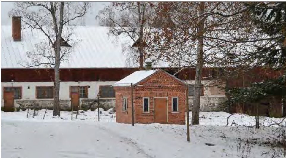
Kuva 36. Kylmähuoneen itäpääty. Taustalla näkyy navetta.
