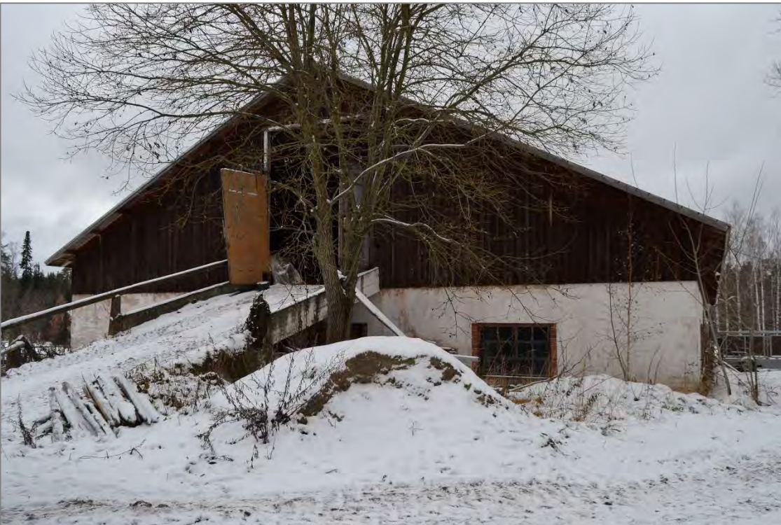
Kuva 40. Betoninen ajoramppi navetan eteläpäädyssä.
