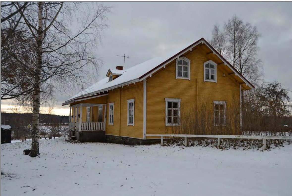
Kuva 27. Rakennuksen pohjoispäätä ja itäisivua.
