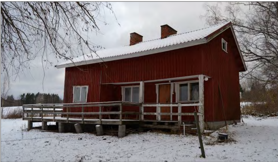
Kuva 42. Saunarakennus kuvattuna rannan puolelta.
