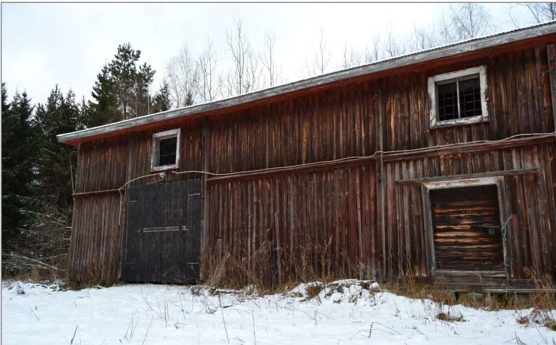
Kuva 54. Rakennuksen itäisivua. Vasemmanpuoleiset ovet vievät nykyisin lahtivajana käytetylle puolelle, oikea ovi museoaittaan.
