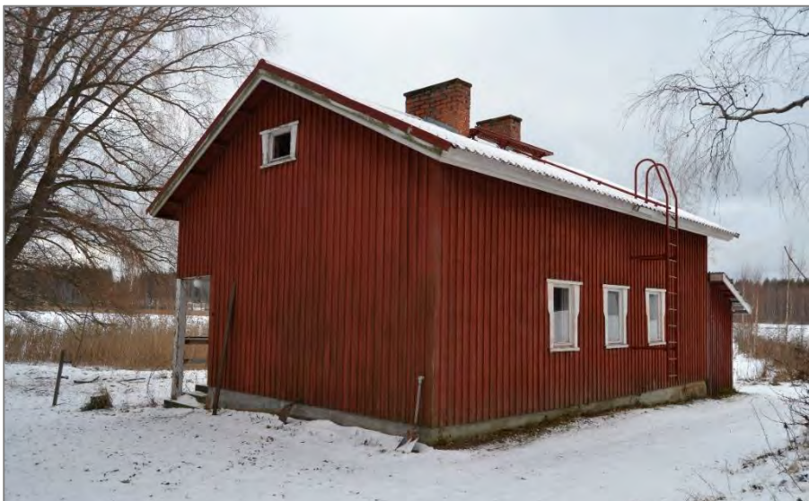
Kuva 43. Saunan itäpäätä ja pohjoissivu.
