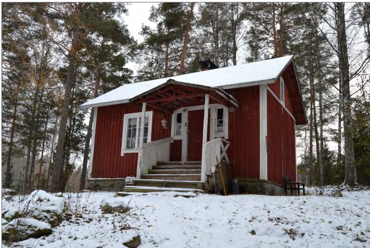
Kuva 48. Rakennus nro 14, itäsivu ja pohjoispääty.
