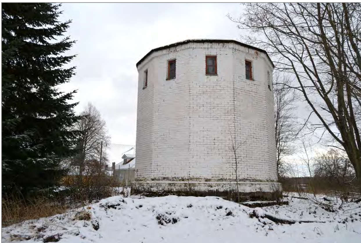
Kuva 41. Rapalan vesitorni kuvattuna lännen puolelta.
