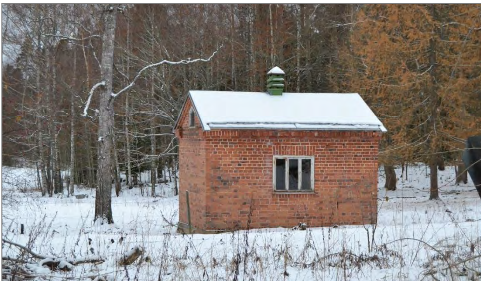
Kuva 37. Rakennuksen eteläsivu ja länsipääty.
