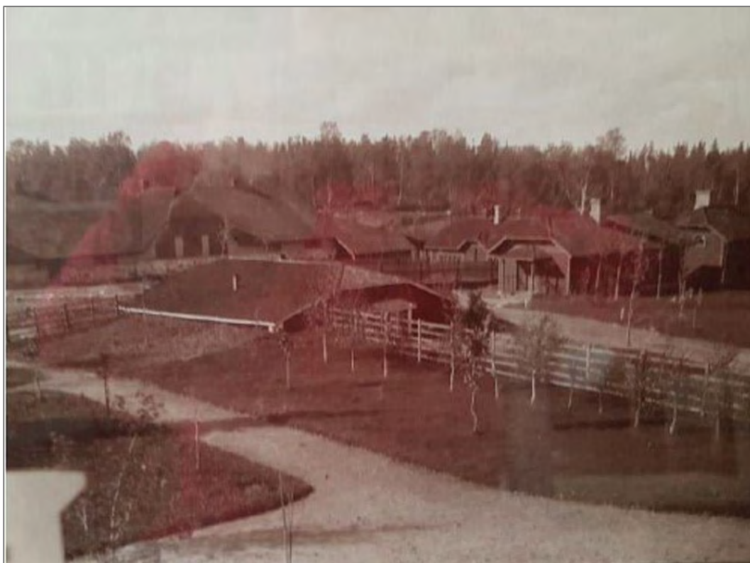
Kuva 33. Kuva Rapalan kartanon talouspihasta 1900-luvun alusta. Kuvan keskivaiheilla näkyy kellari alkuperäisessä asussaan. Sen takana vasemmalla on navetta. Muut kuvassa näkyvät rakennukset on purettu. Kuva: RAP.
