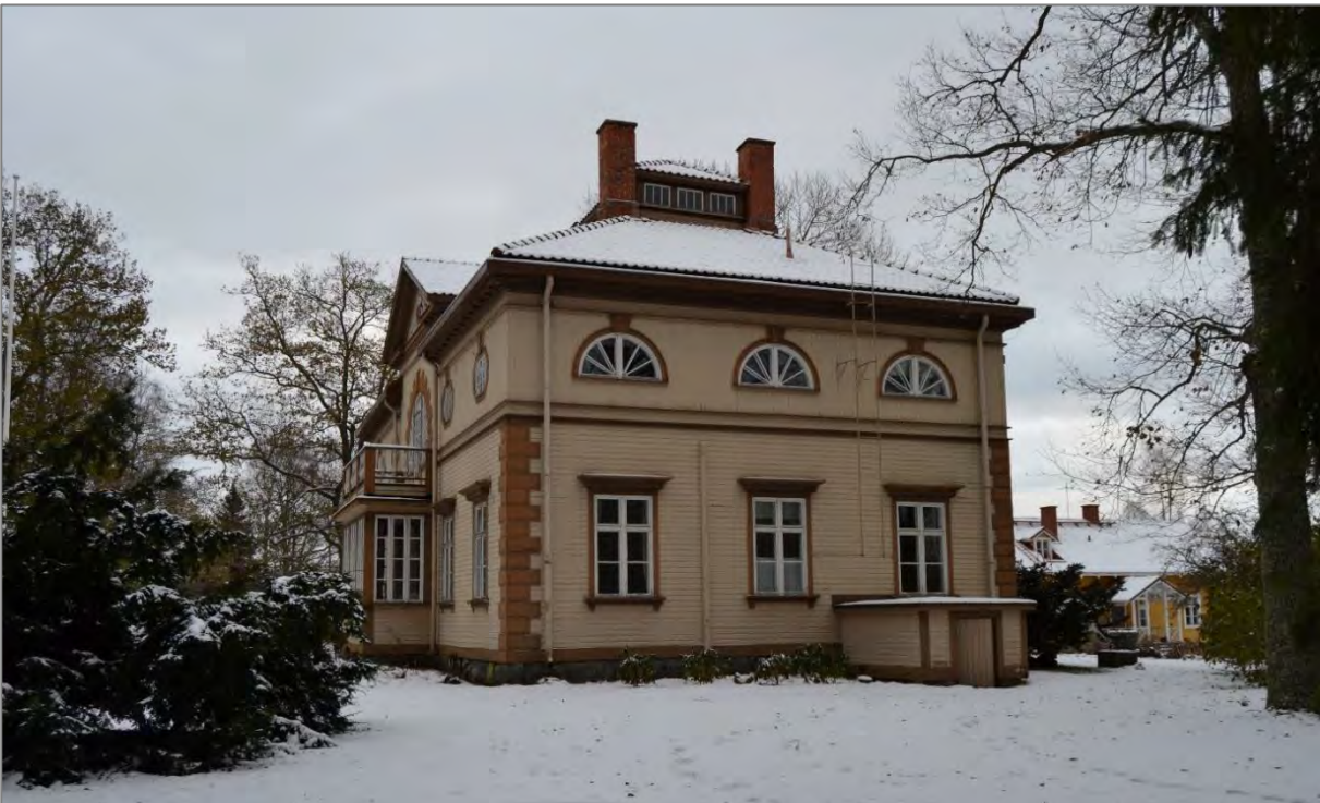
Kuva 20. Päärakennuksen länsipääty ja pohjoissivua. Länsipäädystä on käynti rakennuksen kellarin.
