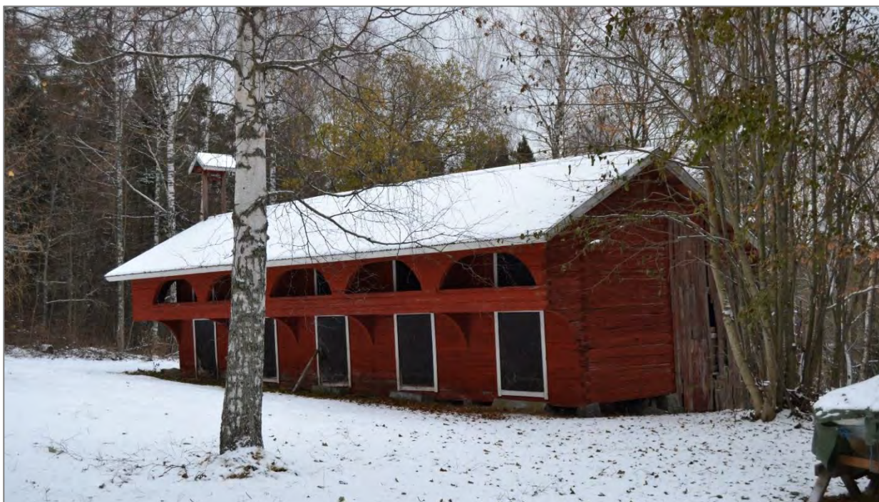
Kuva 30. Luhtiaitan eteläpääty ja länsisivu.
