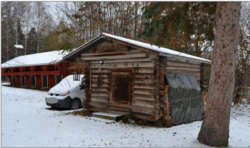
Kuva 28. Aitta kuvattuna lounaiskulmalta.
