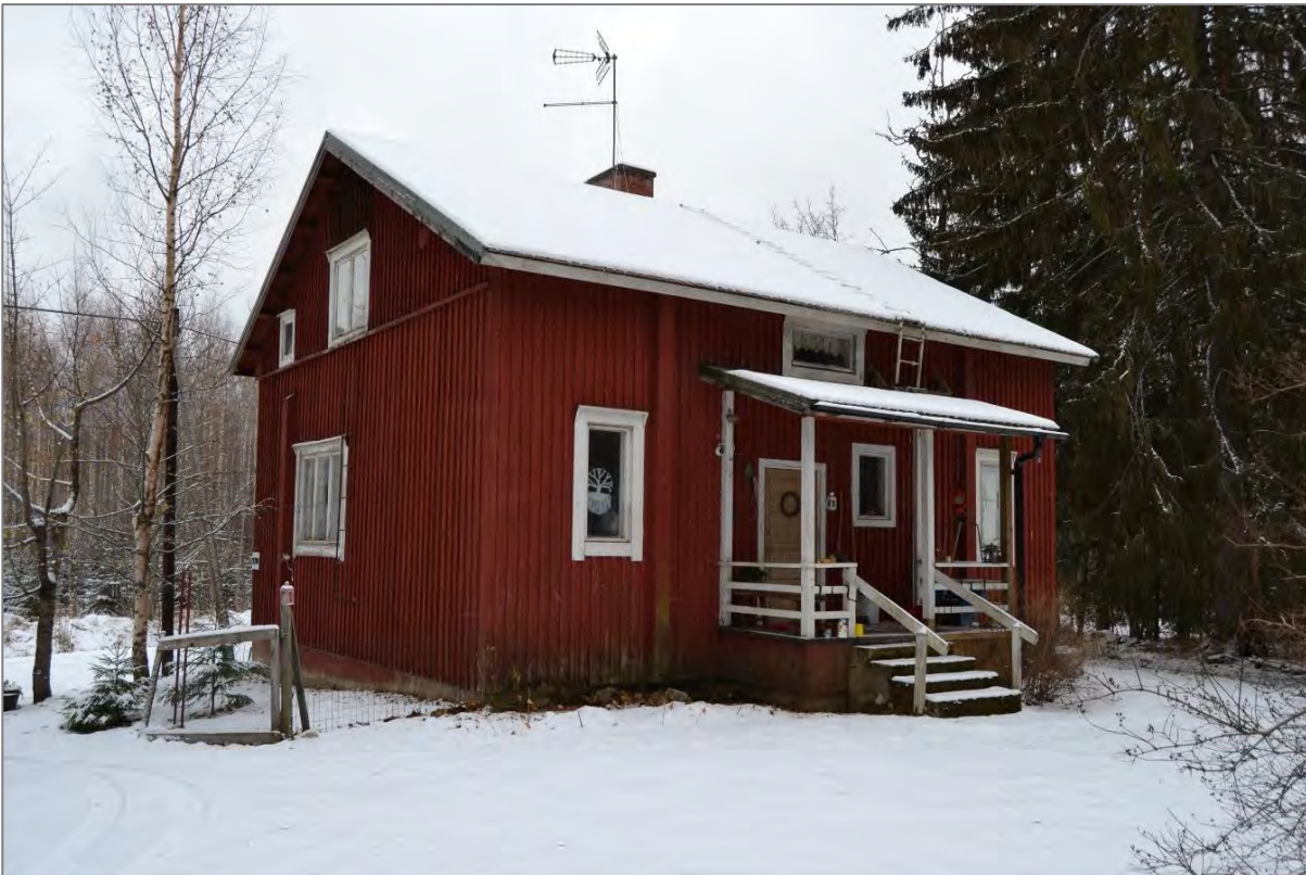
Kuva 55. Rakennuksen pohjoissivu ja itäpääty kuvattuna pihalta. Rakennuksen takana vasemmalla näkyy kartanolle johtava tie.
