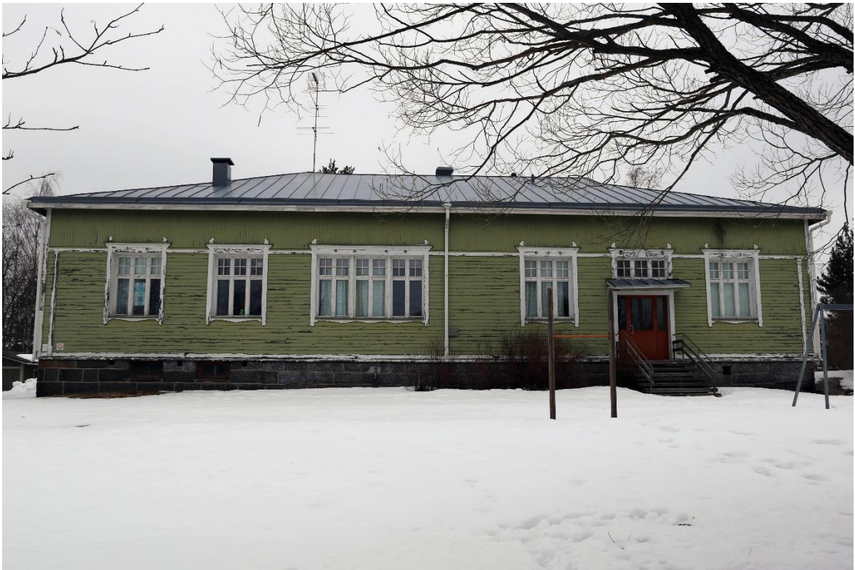
Kuva 3-9. Väihkyläntien varressa sijaitsee 1800–1900-lukujen taitteessa valmistunut Toivolan koulu (Ramboll 2024).
