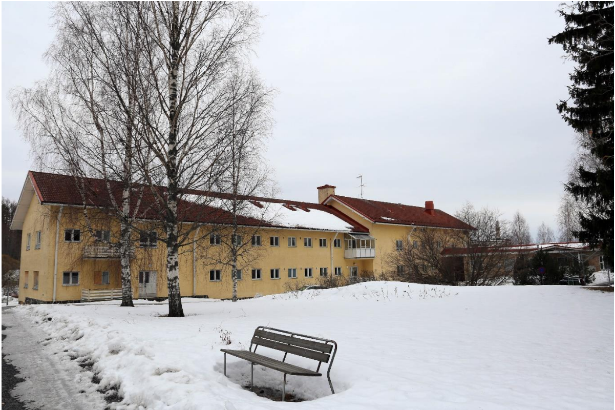
Kuva 3-13. Vuonna 1951 rakennetun vanhainkodin julkisivu pohjoiseen (Ramboll 2024).
