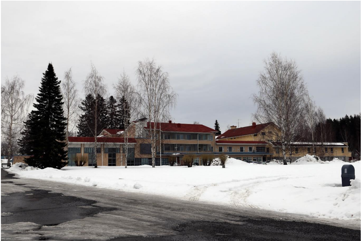
Kuva 3-11. Vanhainkodin julkisivu Leppäkorventielle. Edessä näkyy 1988 ja 1996 rakennetut laajennukset. 1950-luvulla rakennettu osa näkyy korkeampana rakennuksena taustalla. (Ramboll 2024)
