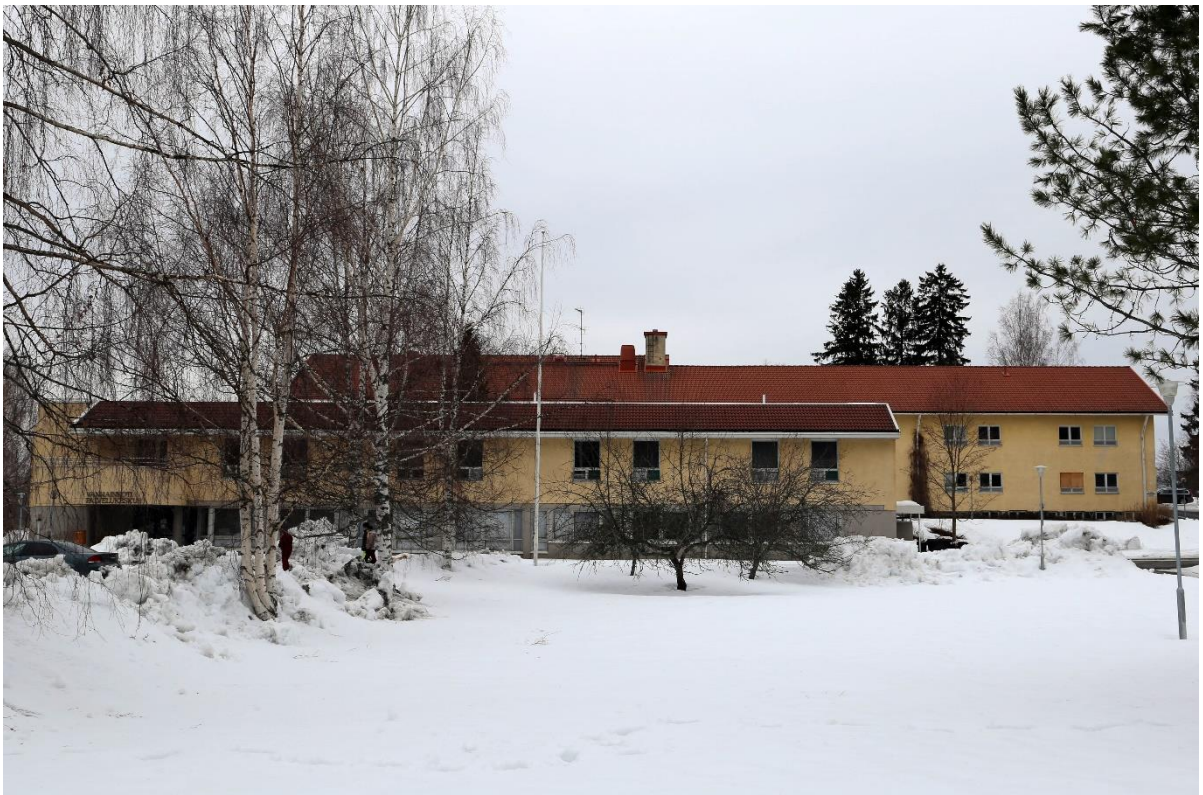
Kuva 3-12. Vanhainkodin julkisivu Toivolantielle. Edessä laajennusosa ja taustalla 1950-luvulla rakennettu rakennusosa. (Ramboll 2024)
