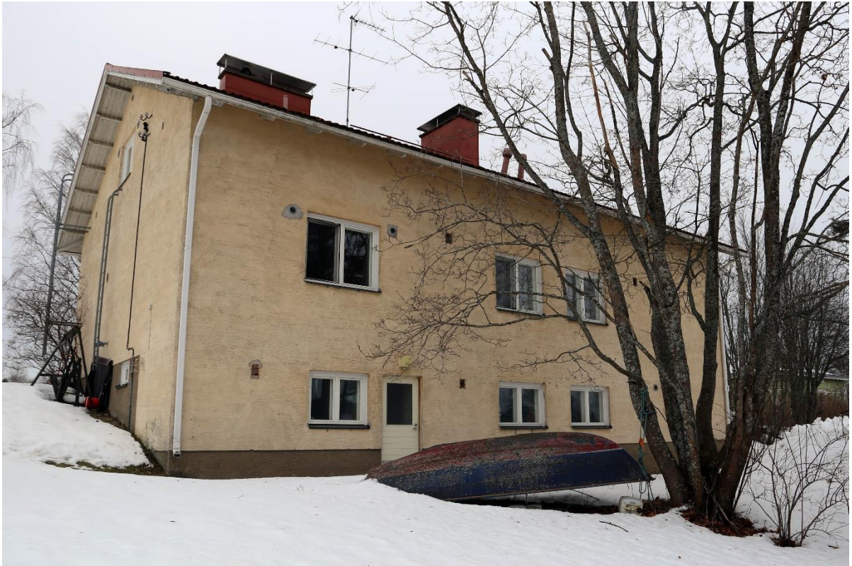
Kuva 3-10. Pajulantien varressa sijaitsee 1950-luvulla valmistunut opettajien asunto (Ramboll 2024).
