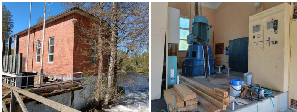
Virtaankosken entinen voimalaitos ulkoa ja sisältä. Voimala lopetti toimintansa vuonna 2012.
