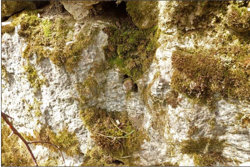
Kaiteenpaikkaa betonissa ja myös kiveen hakattua syvennystä sekä pultin pää
