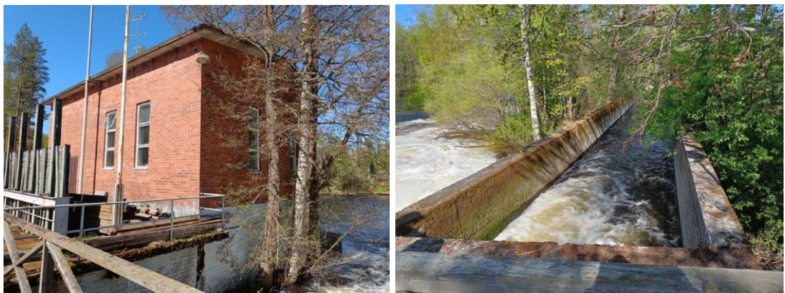
Kuvissa Virtaankosken voimalaitos ja sen ulkorakenteita (5/2022).
